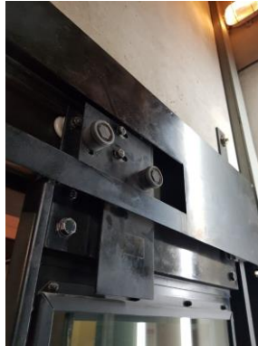
Serrure de porte palière du niveau principal
